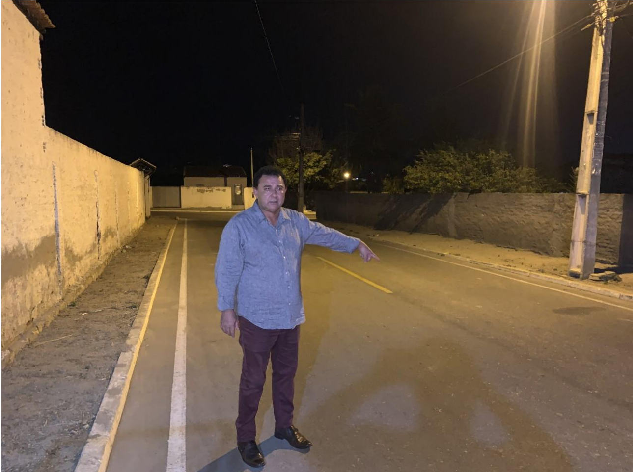
FOTO IN LOCO A PEDIDO DOS MORADORES
