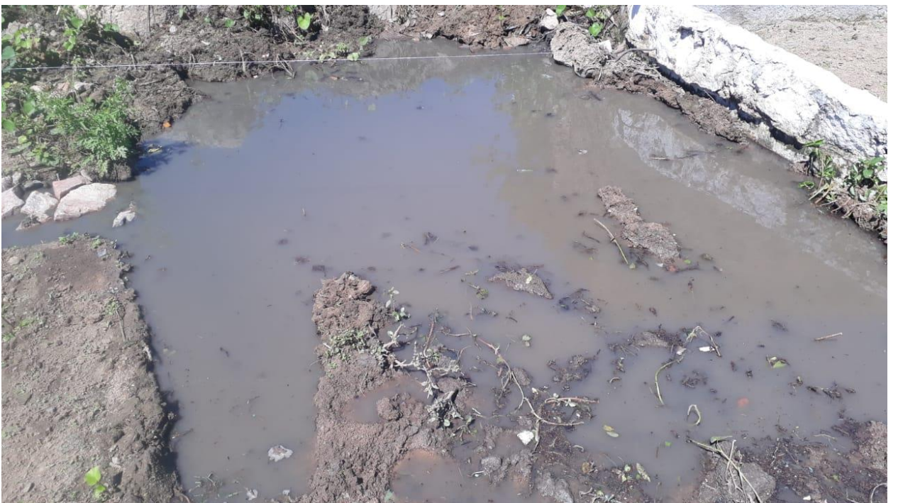
ESGOTO INVADINDO O TERRENO DE POPULARES
