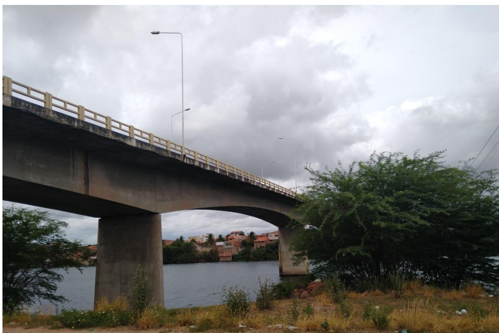
Anexo I – Ponte PCTAN.
